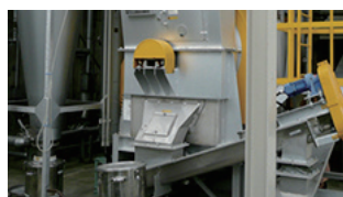
汚泥再資源化施設
